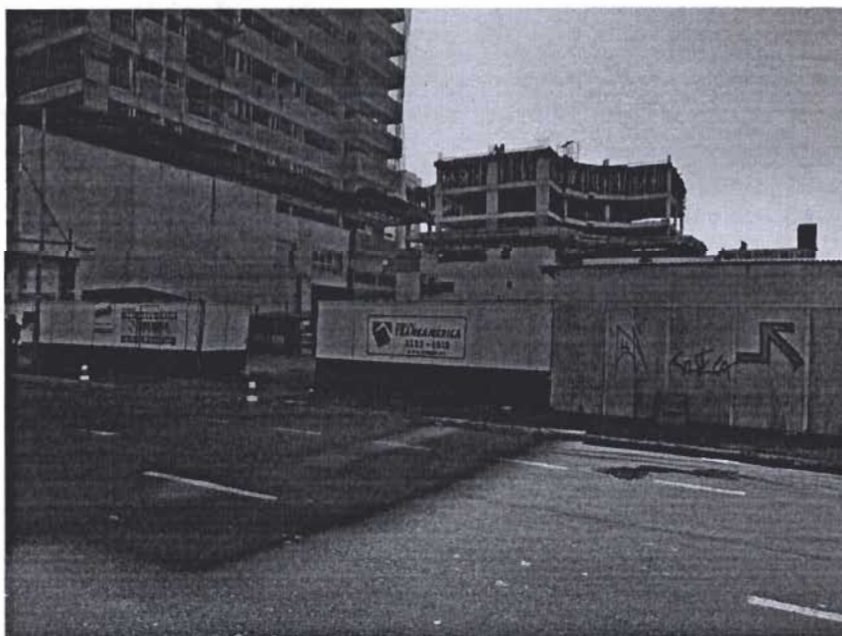
Vista da testada do imóvel Data 51-A/C-4 Quadra 51-A Zona 01, com frente para a Avenida Advogado Horácio Raccanello Filho - Data da Imagem: 19/08/2013
