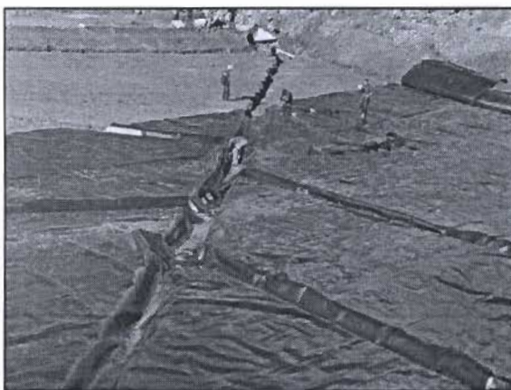
Figura 46 - Cobertura da área com geomembrana e com camada de argila vermelha.
