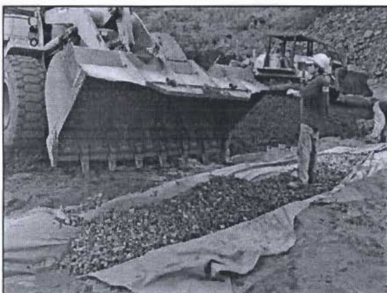
Figura 47 – Adequação das valas para percolação do chorume e vista geral da célula sanitária.
