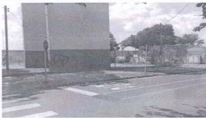
Foto 001 – Área Externa do Imóvel
