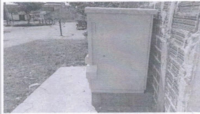
Foto 002 – Área Externa do Imóvel
