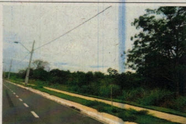
Foto 04 – Vista de lote sem cercamento em fundo de vale na Rua Pioneiro Américo Marega.
