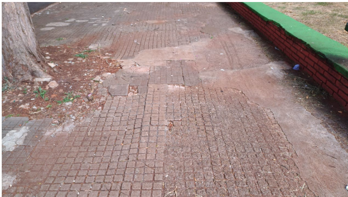
Figura 1: Praça Napoleão Moreira da Silva - Calçamento. Fonte: Foto obtida por meio deste gabinete.
