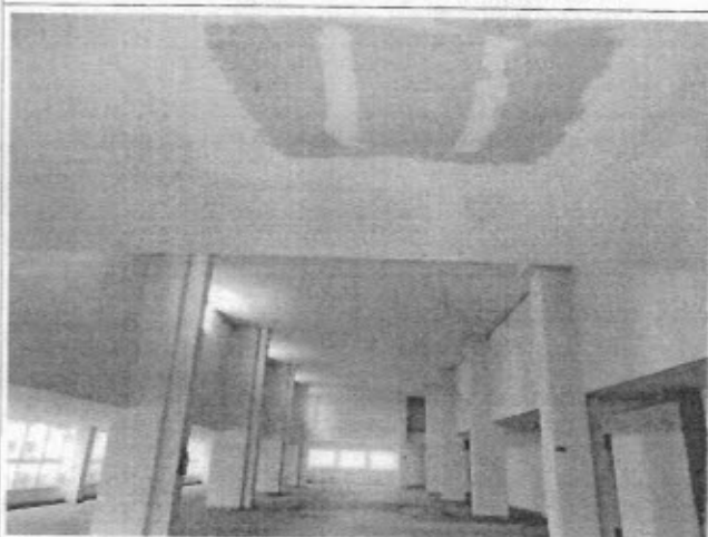
11 - Foto geral sobreloja (sala comercial 02)
