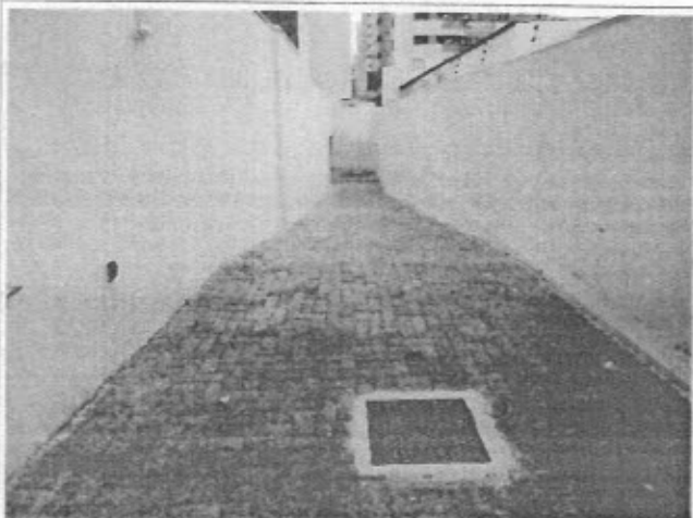
03 - Rampa acesso ao subsolo
