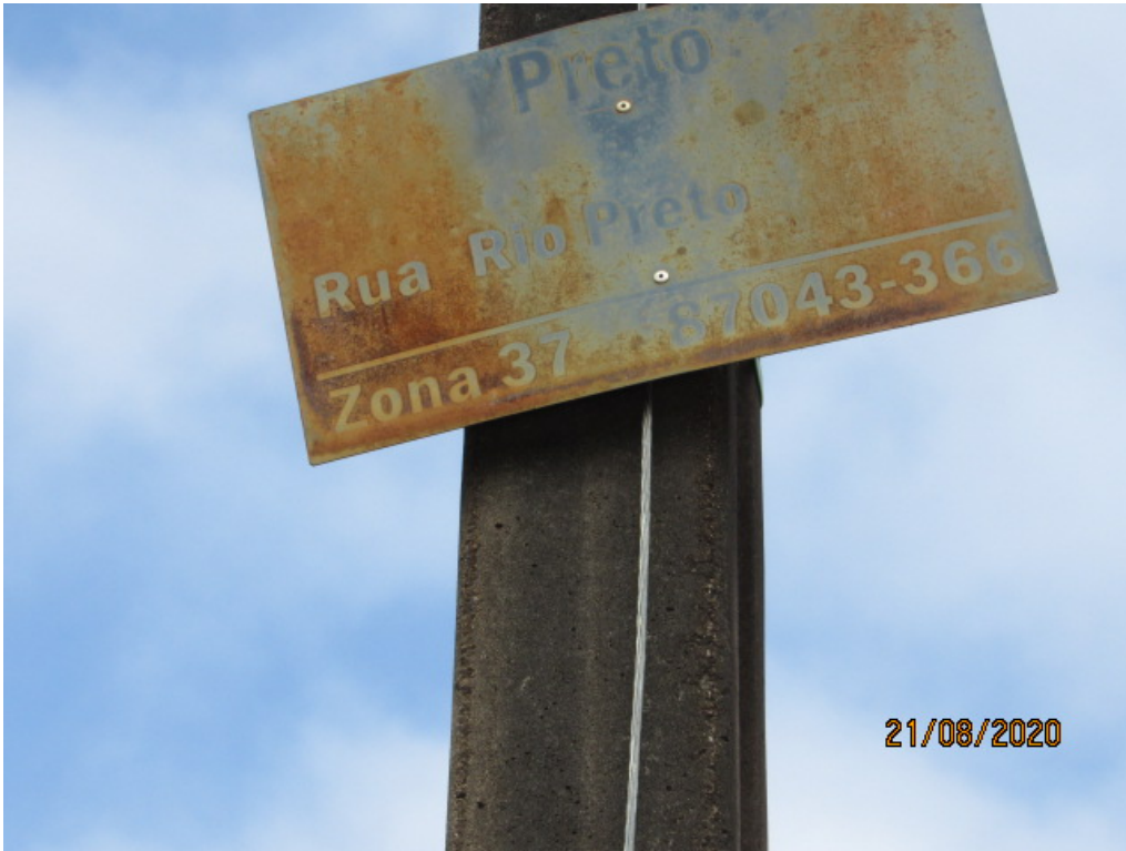
Figura 1: Placa de nomenclatura de rua danificada.
