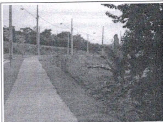
Foto 01: Vista do passeio público na área.
