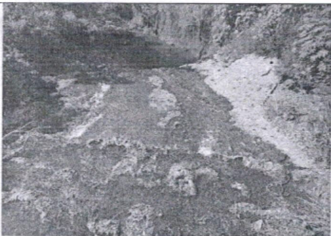
Foto 07 – Vista do Córrego na Rua Palmital.
