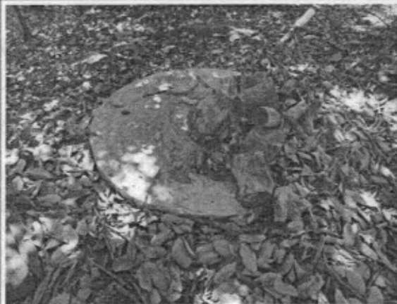
Foto 03: Vista de fossa asséptica no local.
