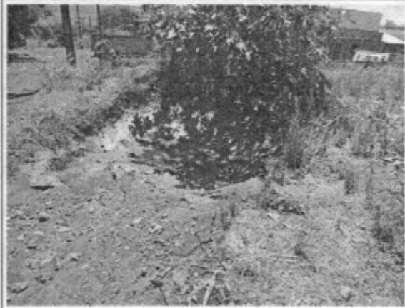
Foto 04: Vista de caixa coletora ao longo da Rua.
