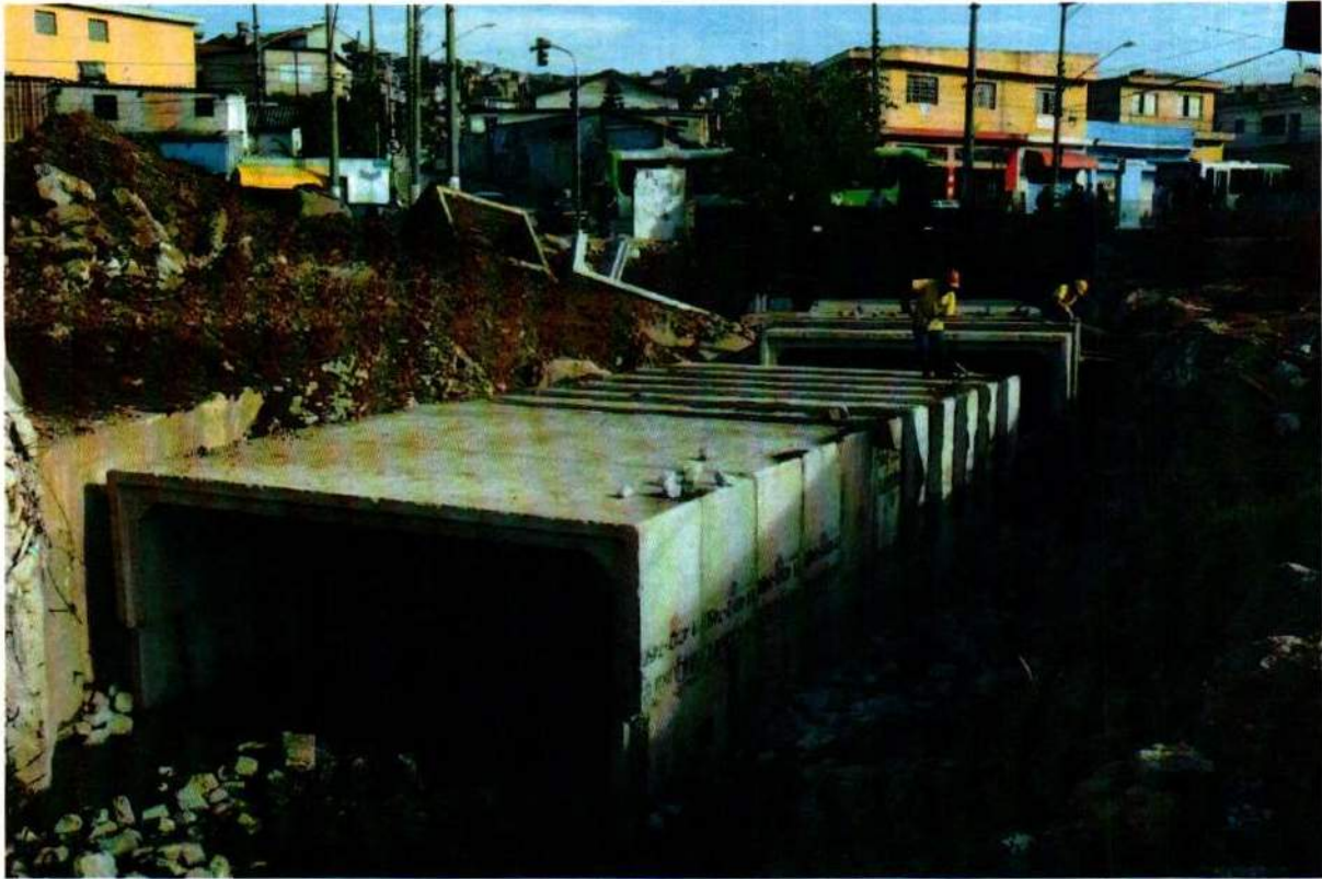
Imagem 2. Rio sendo canalizado no município de São Paulo – SP
