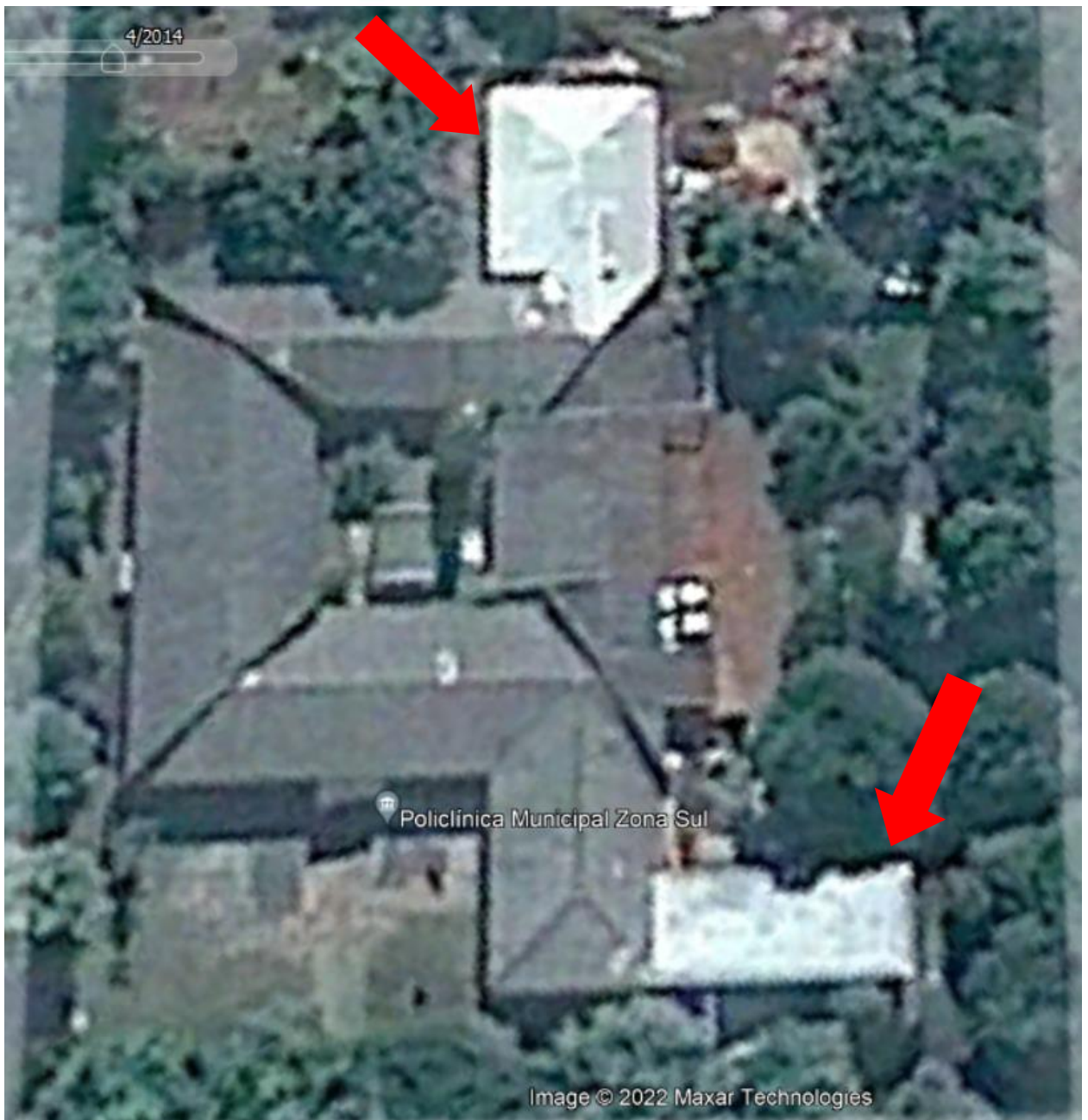
Figura 6. Vista aérea da Policlínica Zona Sul, datada em abril/2014
