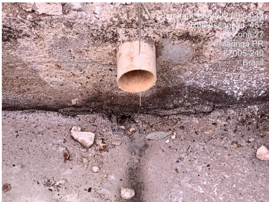
Foto nº 221. Em detalhe a Foto supra.
