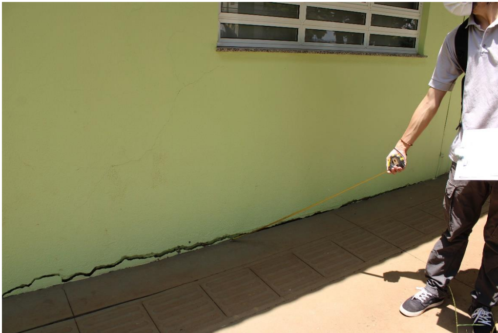
Foto nº 31. Vista parcial da Fachada Frontal, destacando acomodação do calçamento externo.
