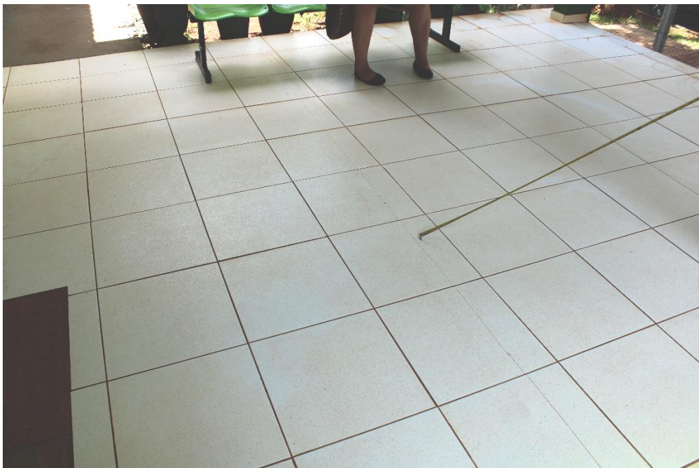
Foto nº 18. Em detalhe a Foto supra.
