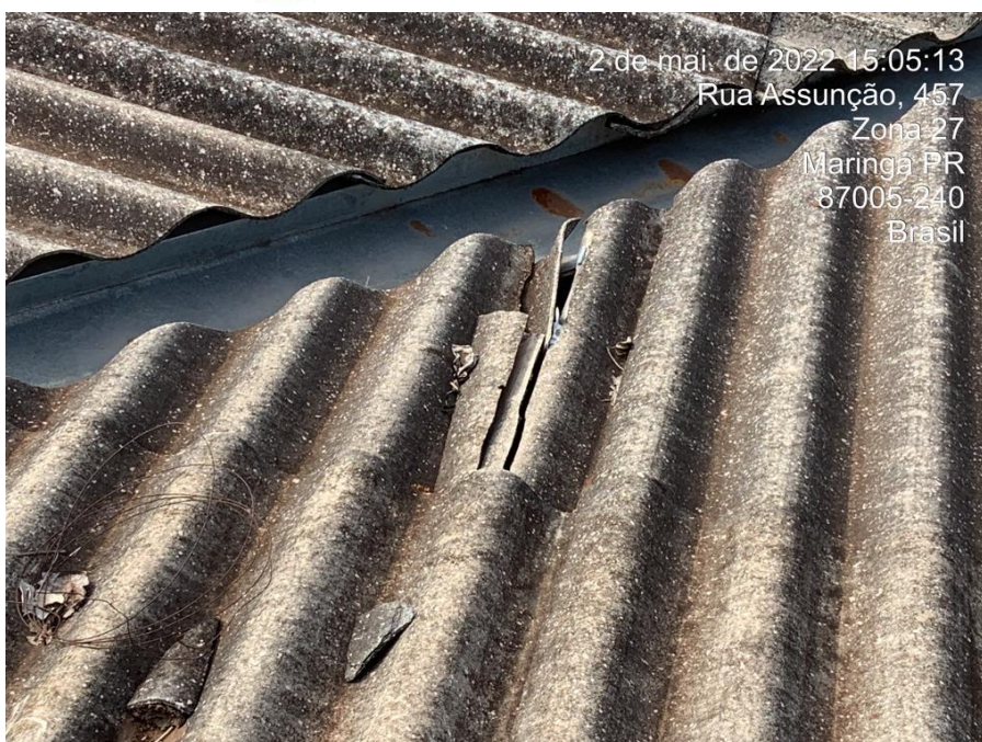
Foto nº 215. Em detalhe a Foto supra.
