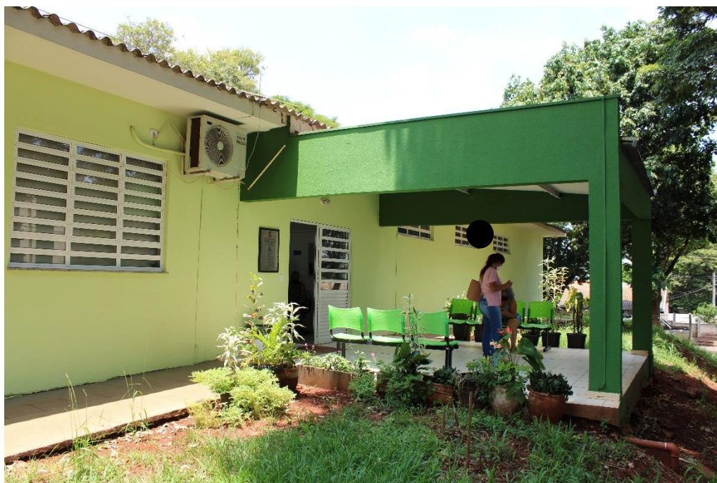
Foto nº 14. Vista parcial da Fachada frontal, destacando área coberta nas proximidades da recepção do CTA.
