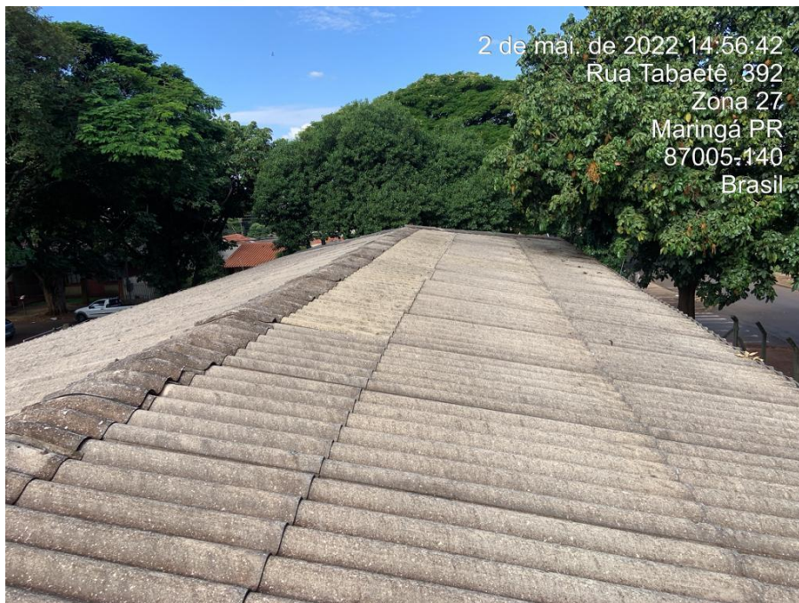
Foto nº 208. Vista parcial da cobertura sobre região ampliada em 2015.
