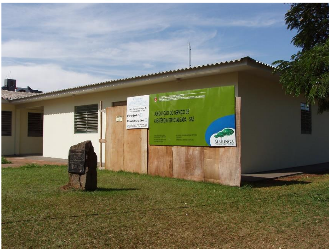
Figura 8. Registro Técnico Fotográfico encaminhado pelo Eng. Civil Rafael, já qualificado, da obra de ampliação (2006/2007) da Policlínica, destacando objeto em apreço.
