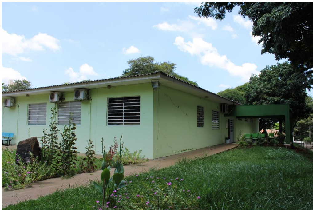
Foto nº 9. Vista da Policlínica Zona Sul.
