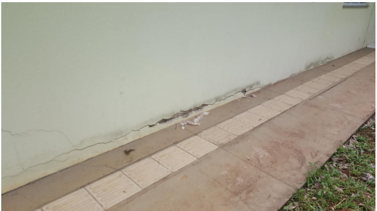
Figura 17. Vista de parede externa (região da coordenação - sala 53), ora qualificada como fachada frontal. Foto data em 29/11/2016.
