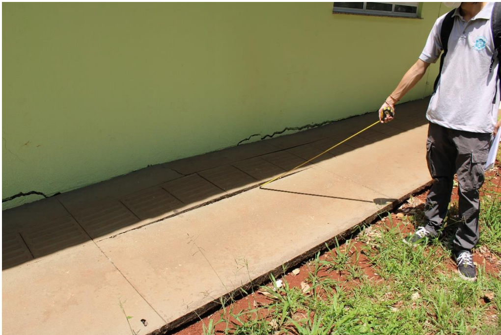
Foto nº 35. Vista parcial da Fachada Frontal, destacando acomodação do calçamento externo.
