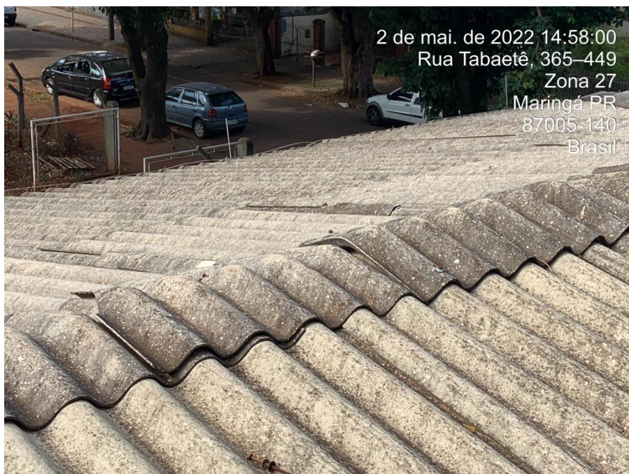
Foto nº 211. Em detalhe a Foto supra.
