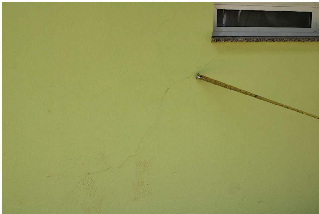
Foto nº 34. Em detalhe a Foto antecessora.
