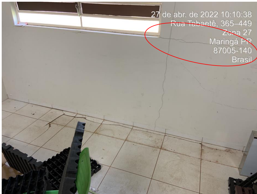
Foto nº 86. Vista parcial da sala 53, destacando fissura horizontal no vértice inferior da janela.
