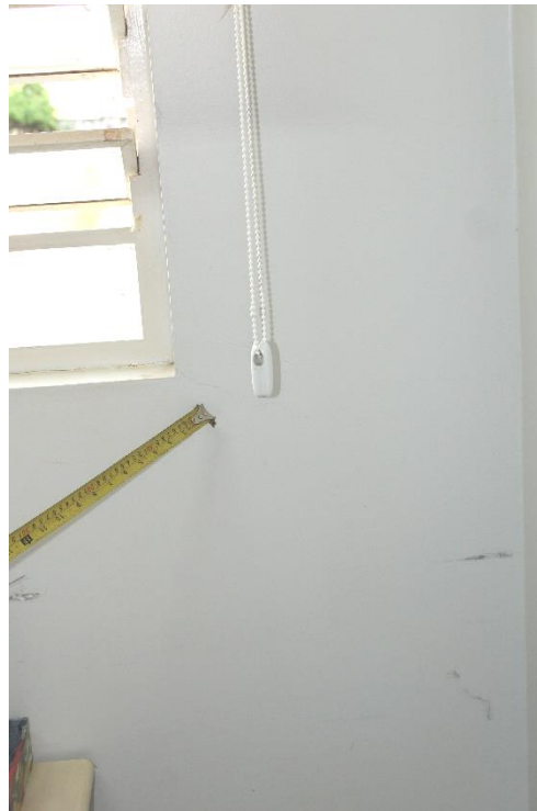
Foto nº 170. Em detalhe a Foto supra.
