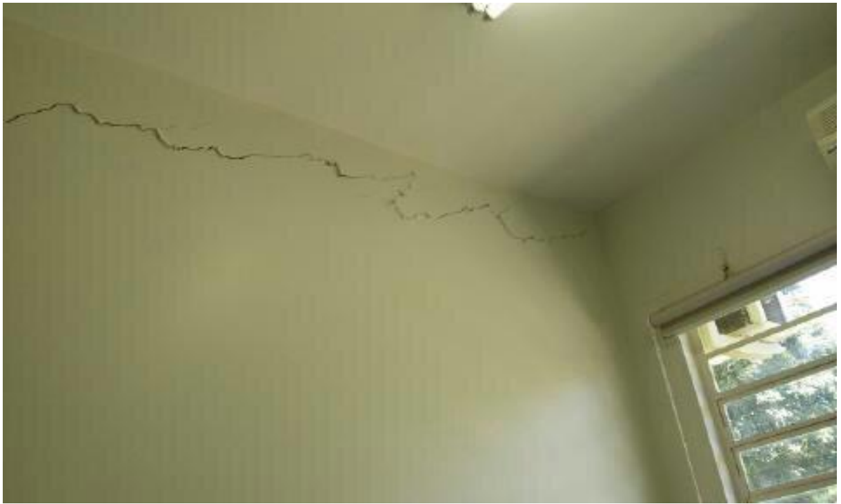
Figura 14. Vista da sala 53. Sem data assertiva.
