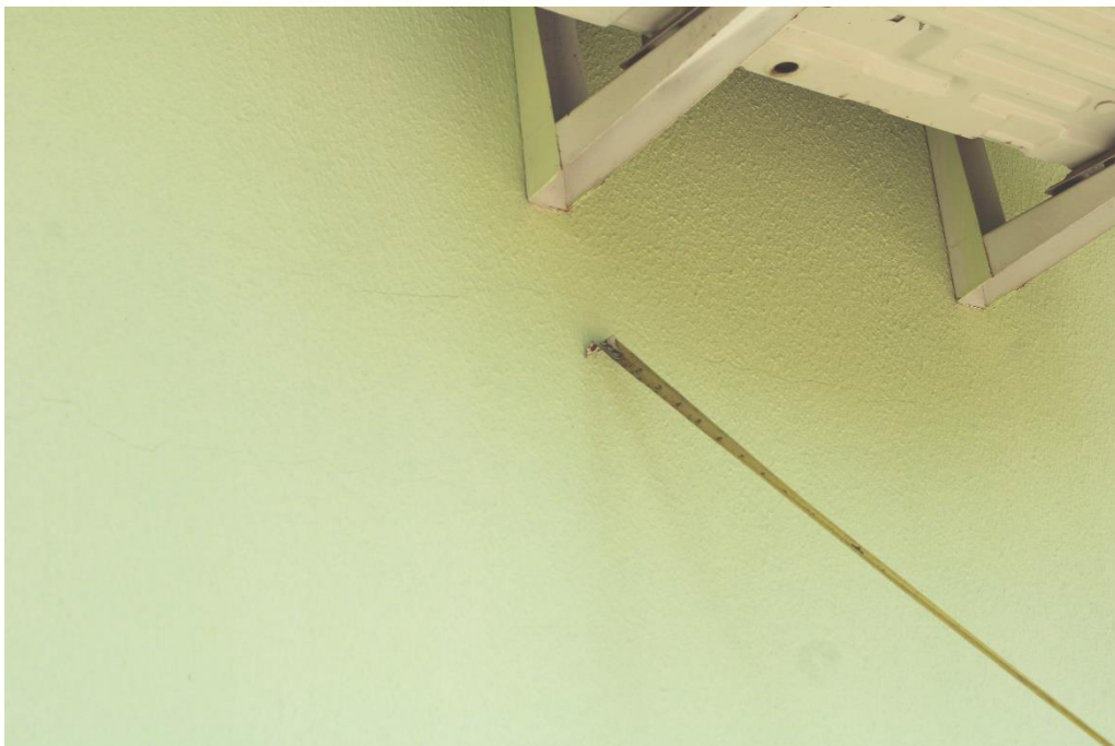
Foto nº 66. Em detalhe a Foto supra.
