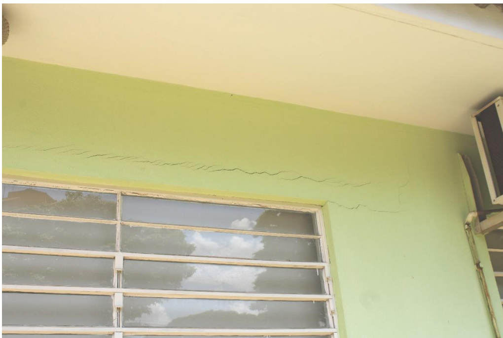
Foto nº 60. Em detalhe a Foto supra.
