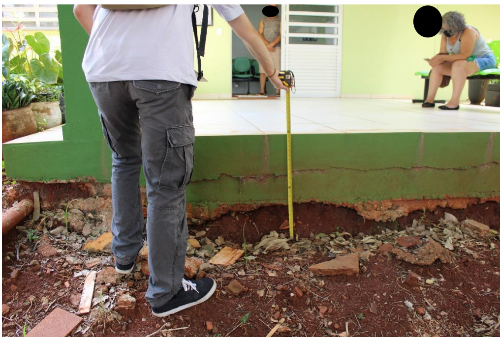
Foto nº 12. Técnico aquilatando magnitude do desconfinamento do solo base do aterro/talude, mediante medição in loco com auxílio de trena graduada.
