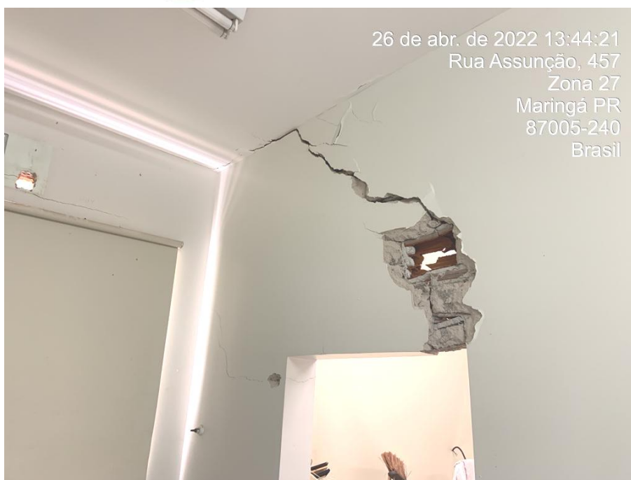
Foto nº 107. Em detalhe a Foto 106, destacando rachadura diagonal sobre abertura, bem como fissura no vértice dessa. Vale pontuar, que não foi identificada verga em concreto.
