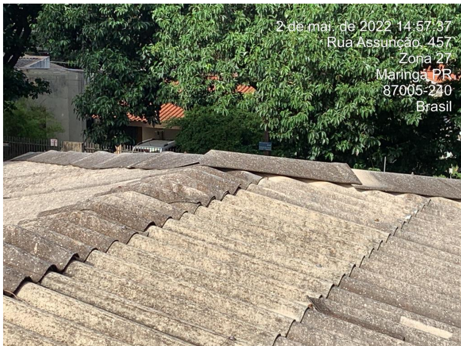
Foto nº 210. Em detalhe a Foto supra.
