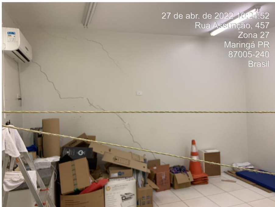
Foto nº 108. Vista da sala 50, destacando trincas diagonais em alvenaria.
