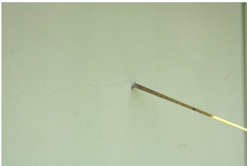
Foto nº 64. Em detalhe a Foto supra.
