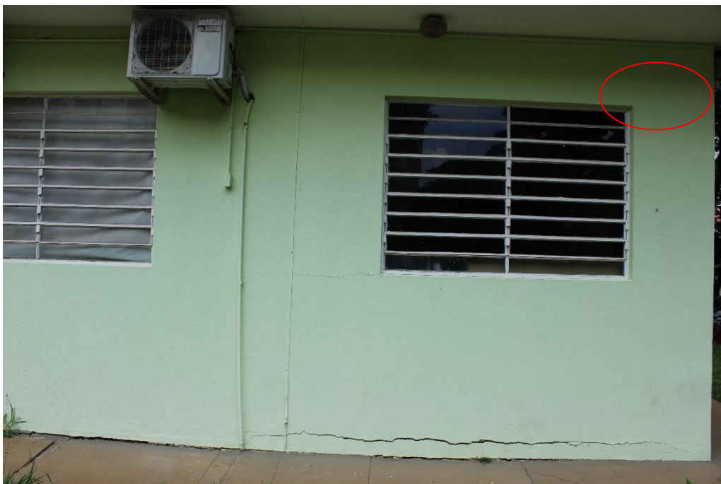
Foto nº 50. Vista parcial da Fachada Lateral Esquerda (região da coordenação - sala 53).
