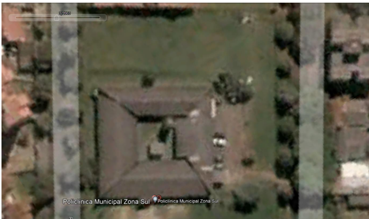
Figura 3. Vista aérea da Policlínica Zona Sul, datada em março/2003. FONTE: Google Earth.
