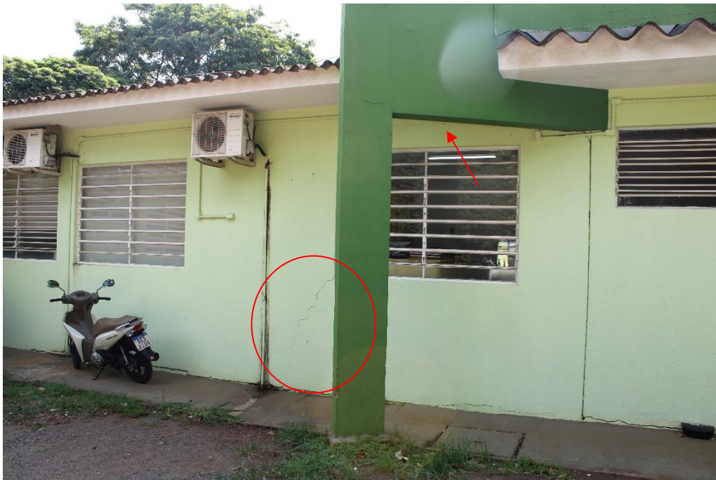
Foto nº 70. Vista parcial da Fachada Lateral Direita (voltada para a rua José Pereira da Costa).
