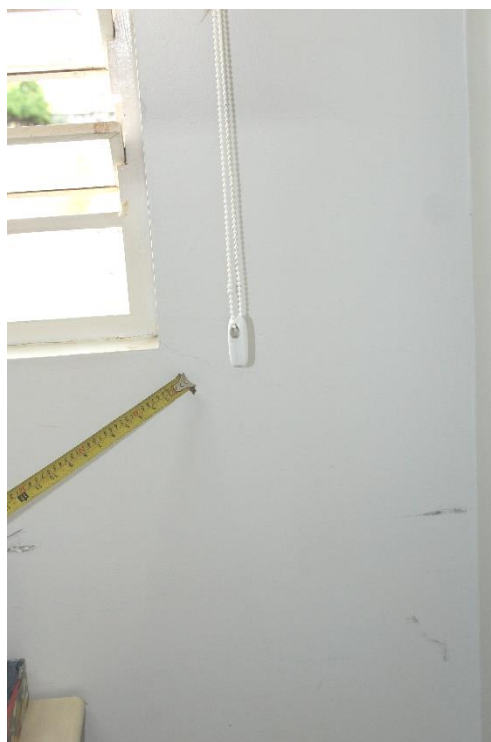
Foto nº 170. Em detalhe a Foto supra.
