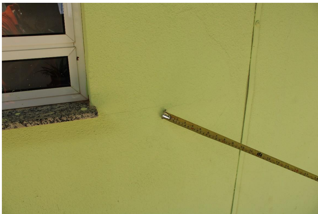
Foto nº 28. Em detalhe a Foto supra.
