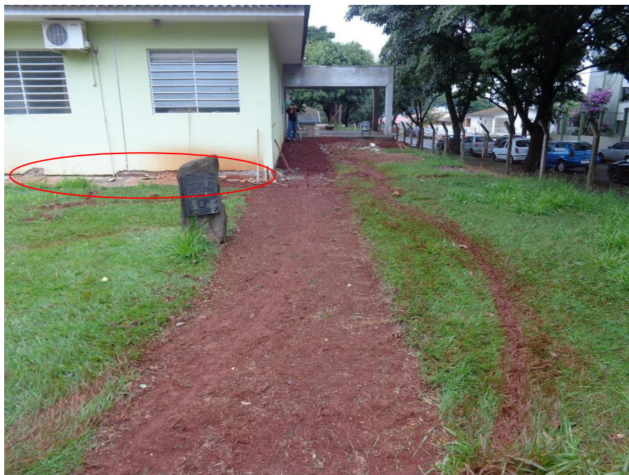
Figura 10. Registro Técnico Fotográfico encaminhado pelo Eng. Civil Rafael, já qualificado, da obra de ampliação da Policlínica (2014/2015).
