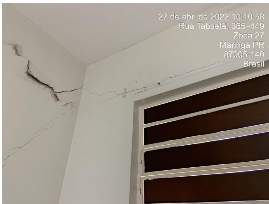
Foto nº 83. Em detalhe a Foto supra, destacando trinca horizontal sobre janela.
