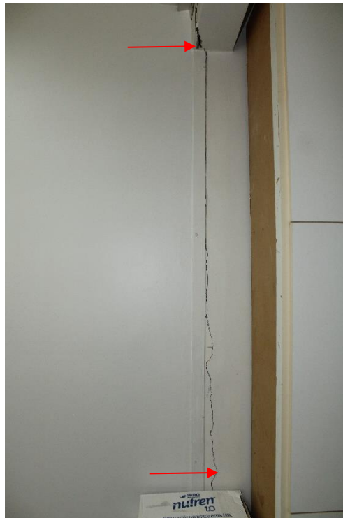
Foto nº 187. Em detalhe a Foto supra.
