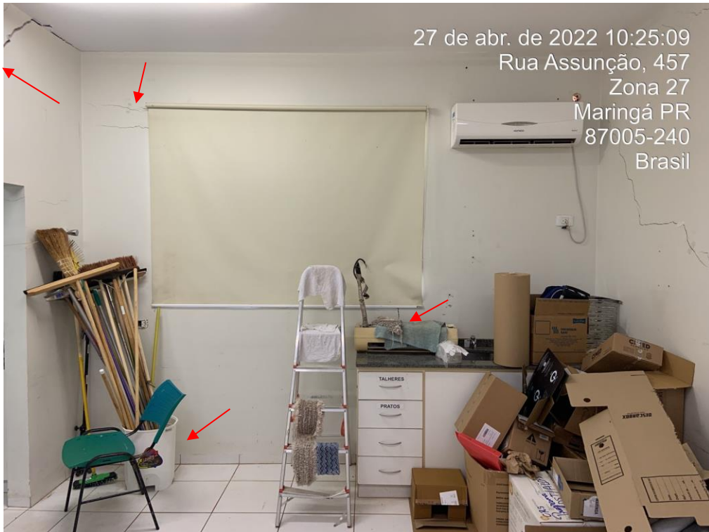
Foto nº 111. Vista parcial da sala 50, destacando trinca e fissuras em alvenaria.
