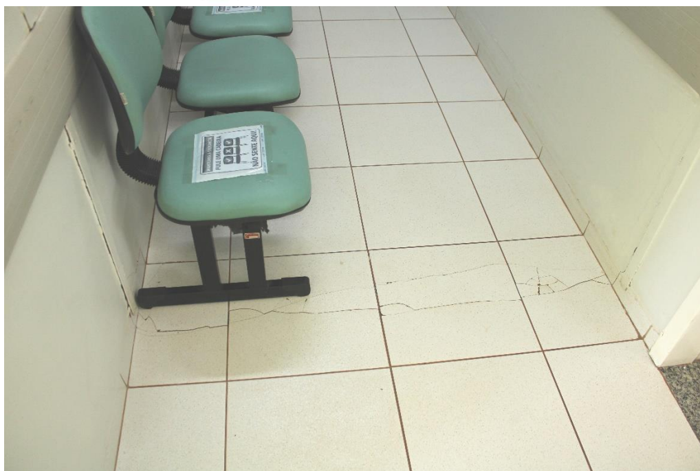
Foto nº 97. Em detalhe a Foto supra.
