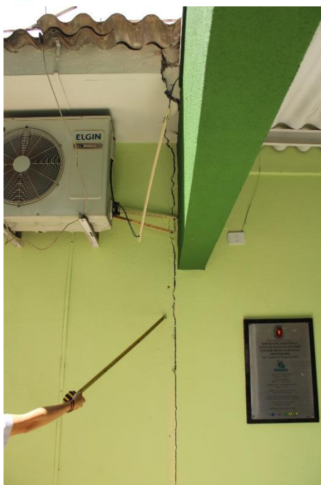
Foto nº 25. Trinca conformação vertical na região de interface entre os blocos construtivos supra qualificados.
