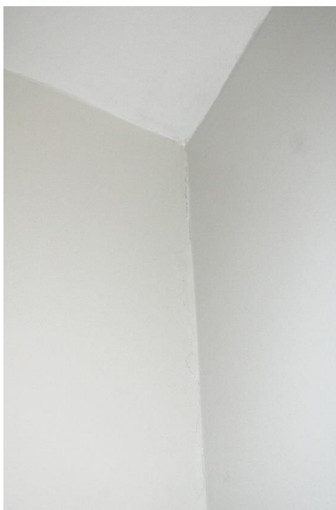
Foto nº 180. Em detalhe a Foto supra.
