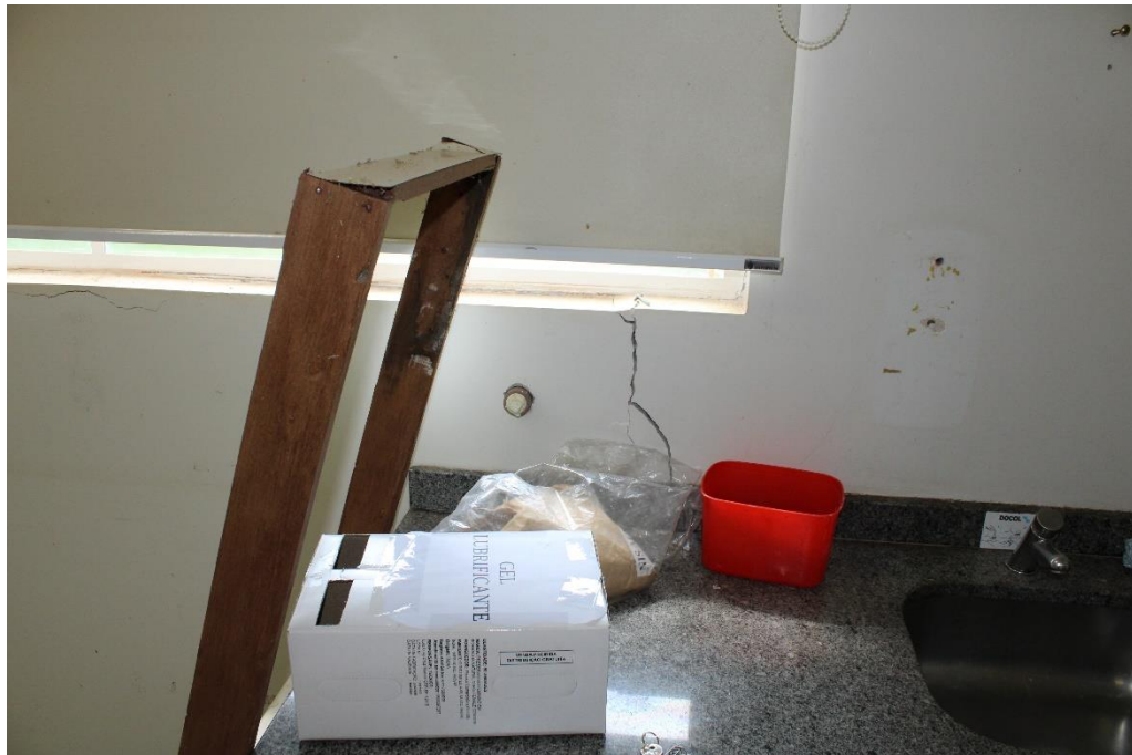
Foto nº 112. Em detalhe a foto acima, destacando trinca de conformação vertical.
