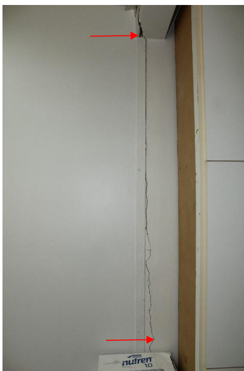
Foto nº 187. Em detalhe a Foto supra.
