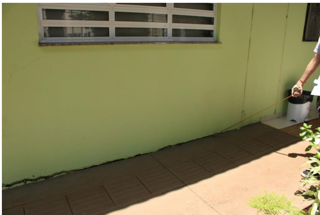
Foto nº 29. Vista parcial da Fachada Frontal, destacando acomodação do calçamento externo.
