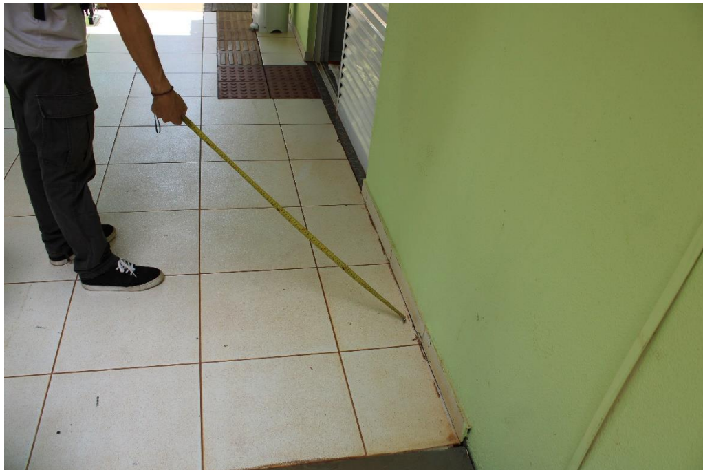
Foto nº 19. Vista da área coberta, já qualificada, destacando acomodação do piso.
