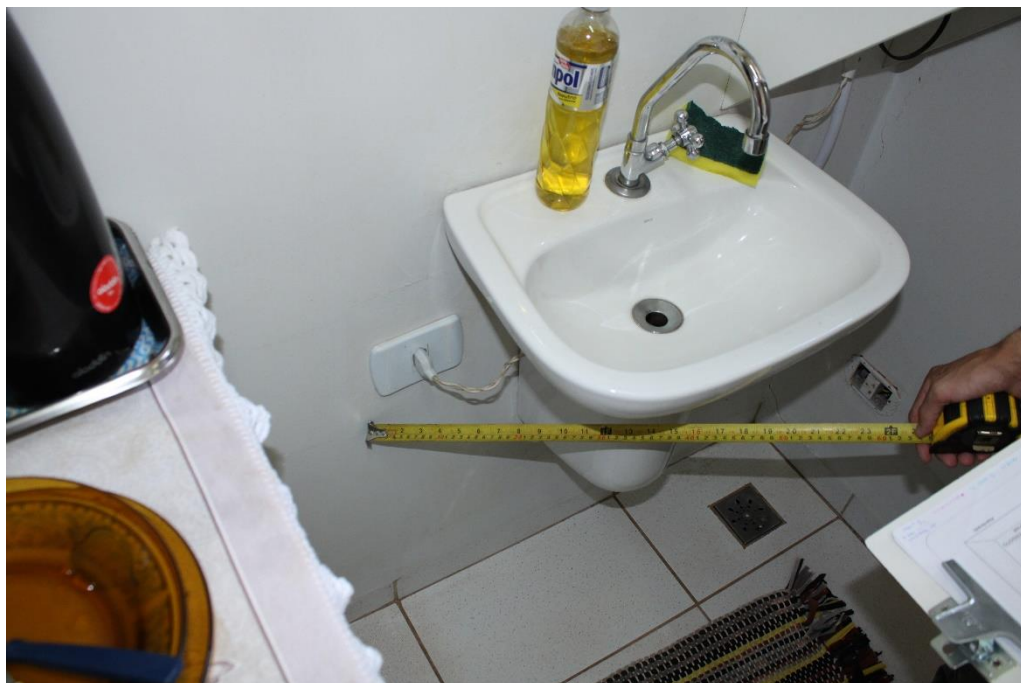
Foto nº 173. Vista parcial da sala 49, destacando fissura horizontal em alvenaria.
