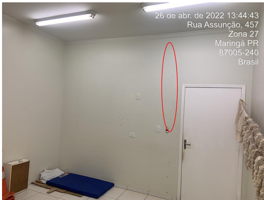
Foto nº 118. Vista parcial da sala 50, destacando fissura de conformação vertical em alvenaria.
