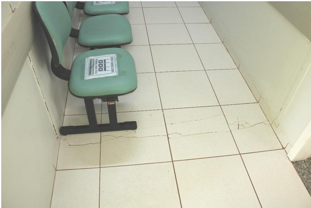
Foto nº 97. Em detalhe a Foto supra.
