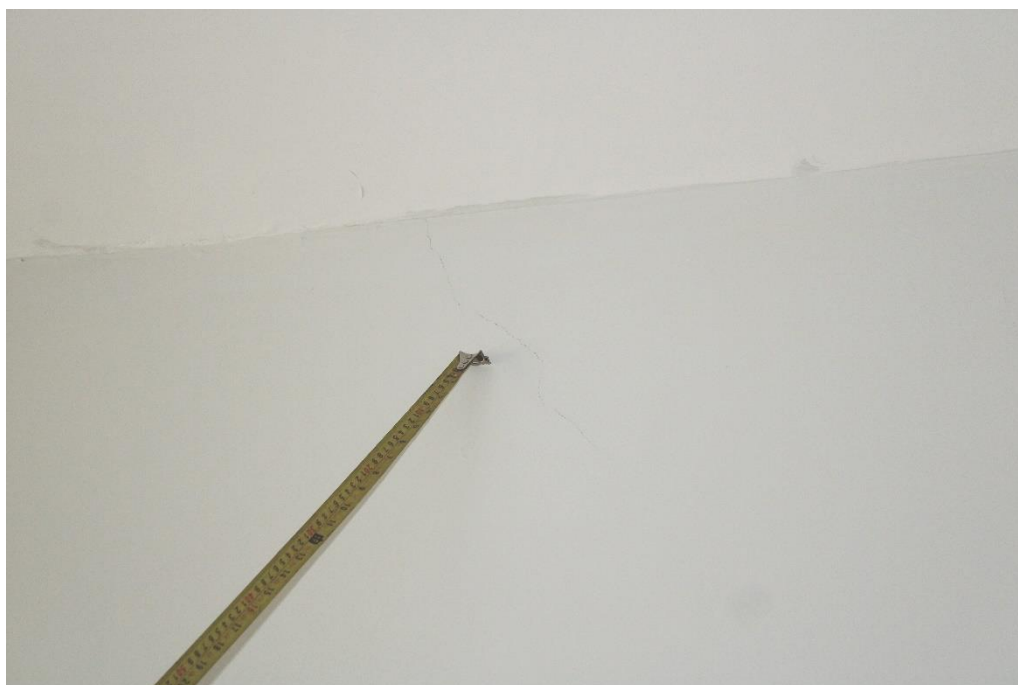
Foto nº 161. Em detalha a Foto acima, destacando fissura em alvenaria.
