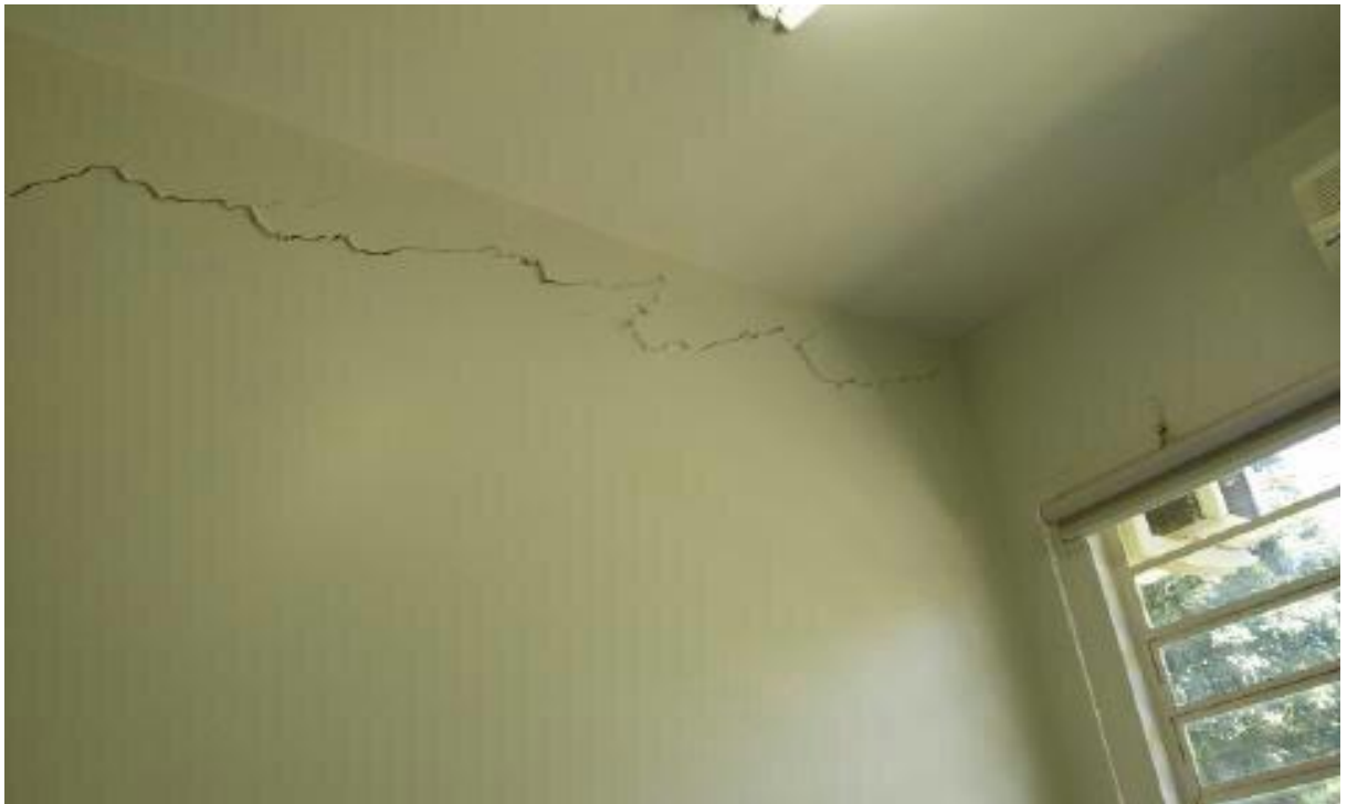
Figura 14. Vista da sala 53. Sem data assertiva.
