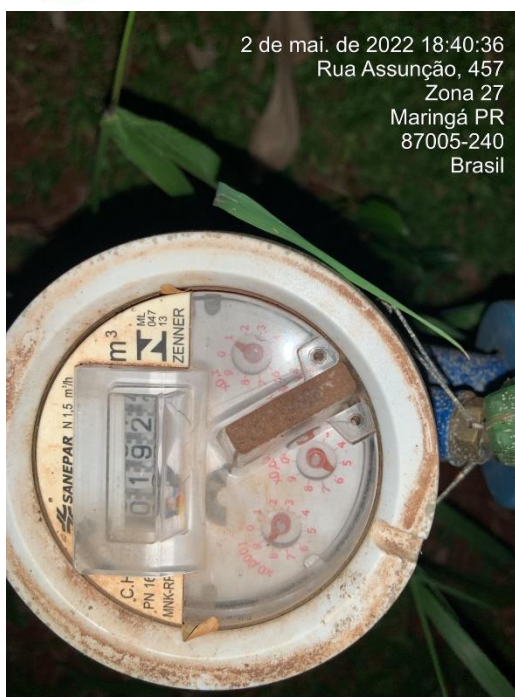
Foto nº233: Aferição do hidrômetro, apontando alteração de medida após a abertura do registro.
