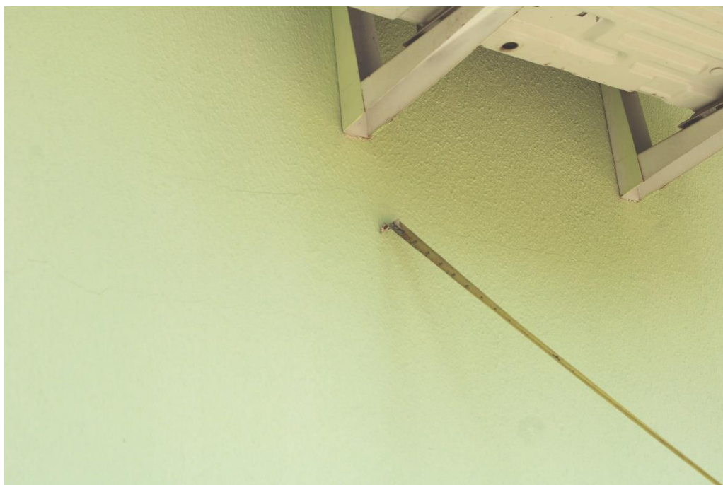
Foto nº 66. Em detalhe a Foto supra.
