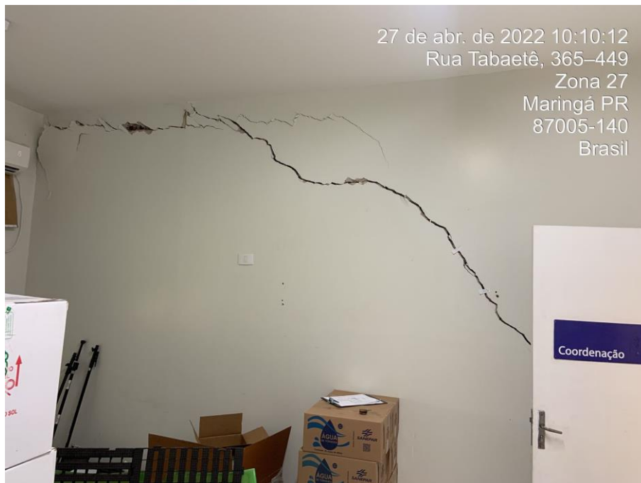
Foto nº 87. Vista parcial da sala 53, destacando trinca de conformação diagonal em alvenaria.
