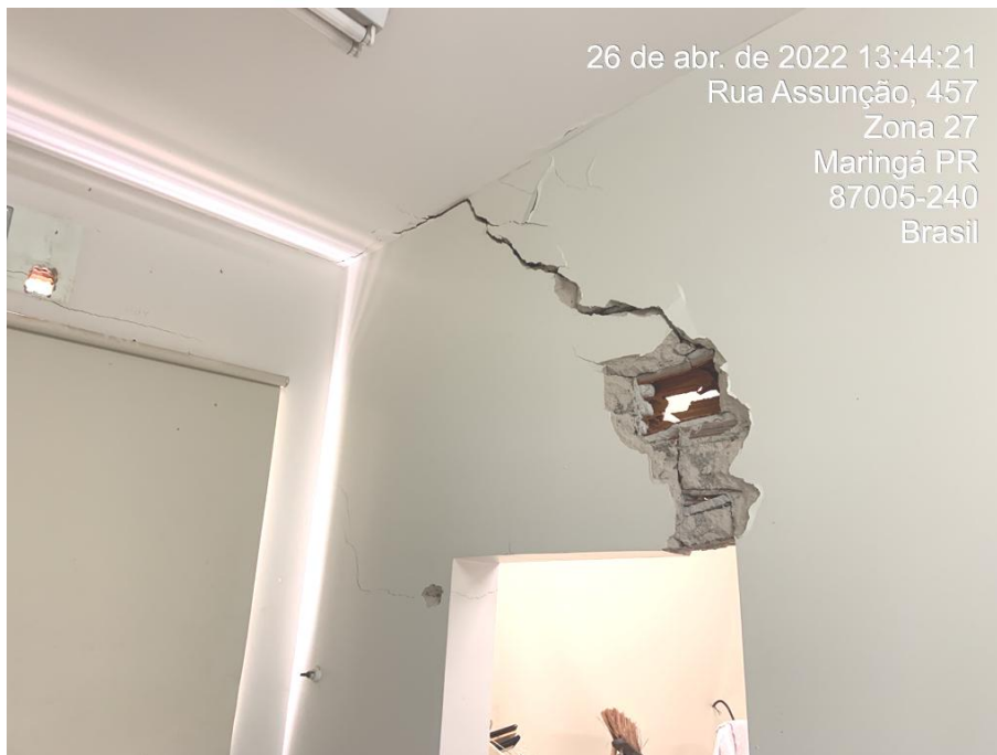
Foto nº 107. Em detalhe a Foto 106, destacando rachadura diagonal sobre abertura, bem como fissura no vértice dessa. Vale pontuar, que não foi identificada verga em concreto.
