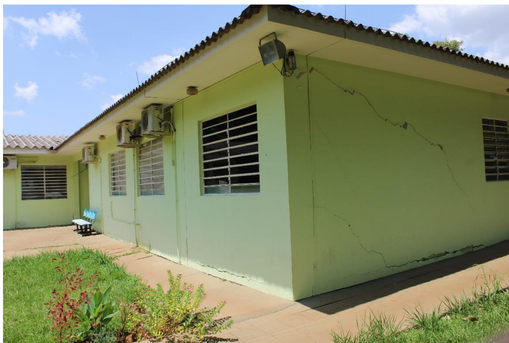
Foto nº 46. Vista parcial da Fachada Frontal/Lateral Esquerda do objeto em apreço.
