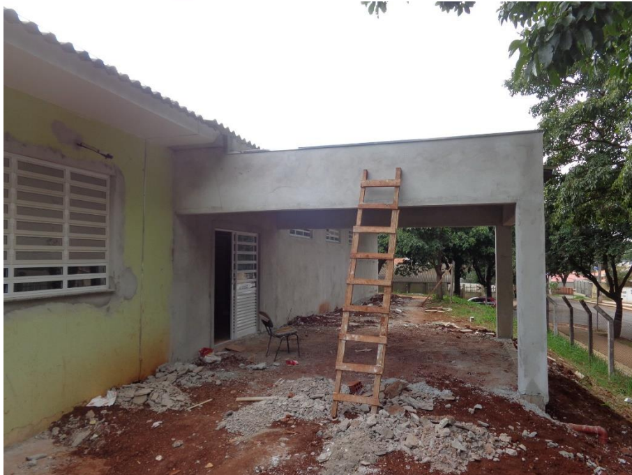
Figura 9. Registro Técnico Fotográfico encaminhado pelo Eng. Civil Rafael, já qualificado, da obra de ampliação da Policlínica (2014/2015).
