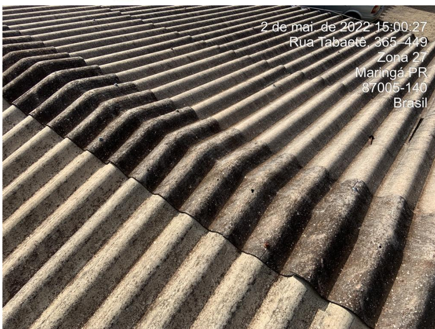
Foto nº 211. Em detalhe a Foto supra.
