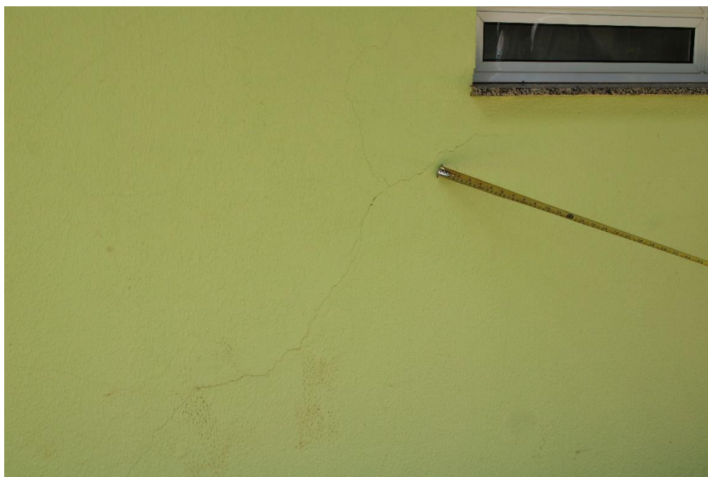
Foto nº 34. Em detalhe a Foto antecessora.
