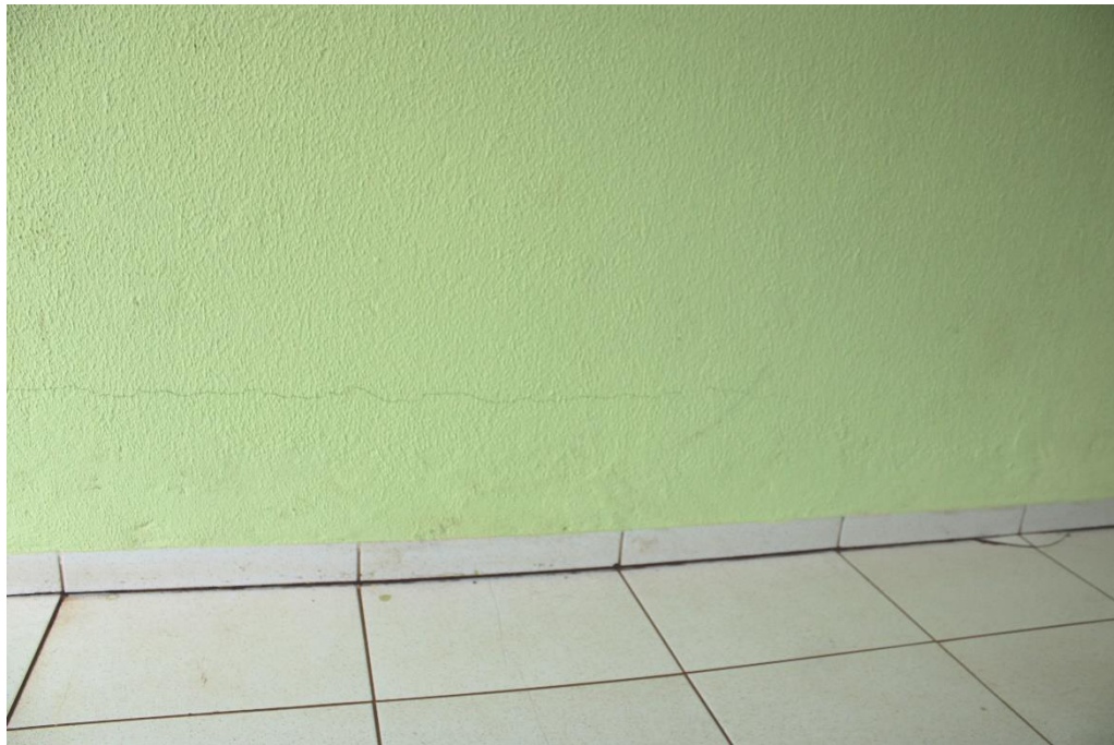
Foto nº 131. Em detalhe a Foto supra.
