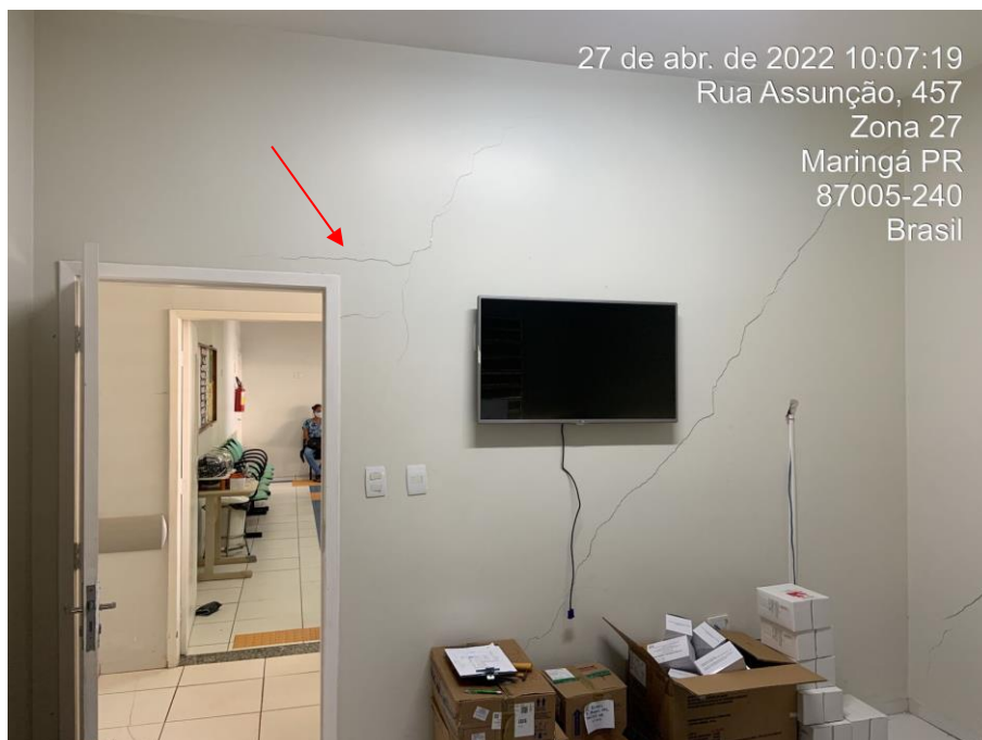
Foto nº 88. Vista parcial da sala 53, destacando trincas em alvenaria.
