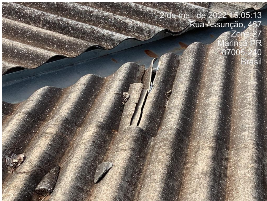
Foto nº 215. Em detalhe a Foto supra.
