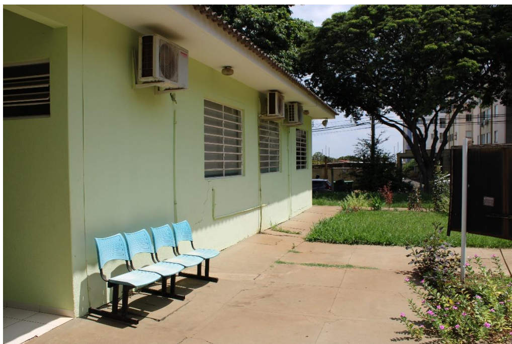
Foto nº 68. Vista geral da Fachada Lateral Esquerda do objeto em apreço.
