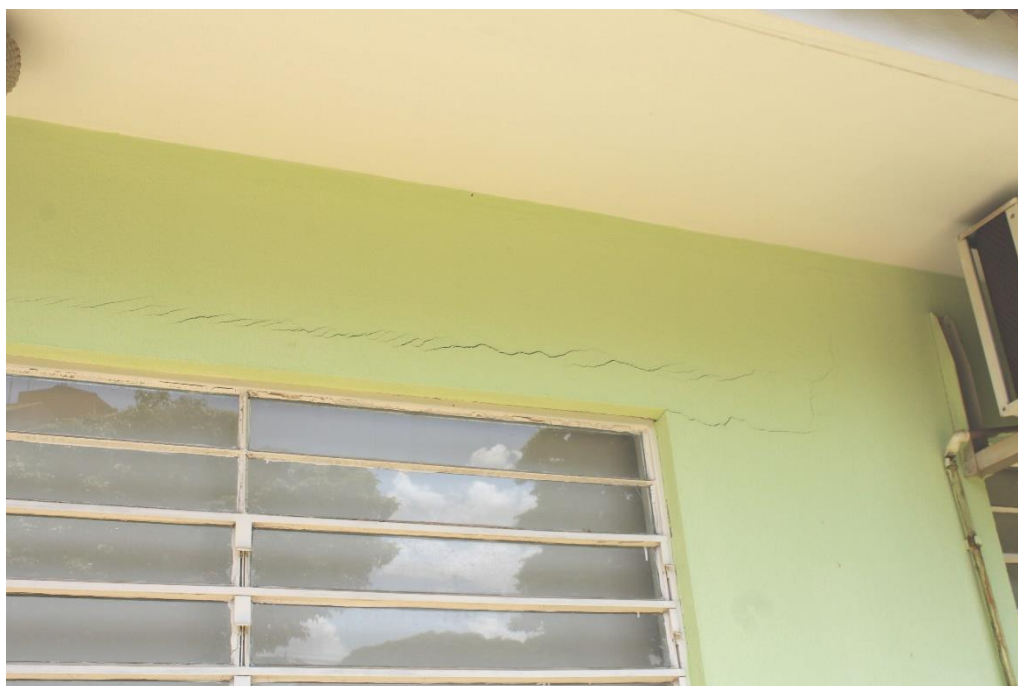
Foto nº 60. Em detalhe a Foto supra.
