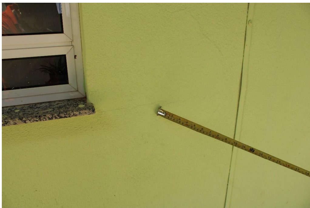
Foto nº 28. Em detalhe a Foto supra.
