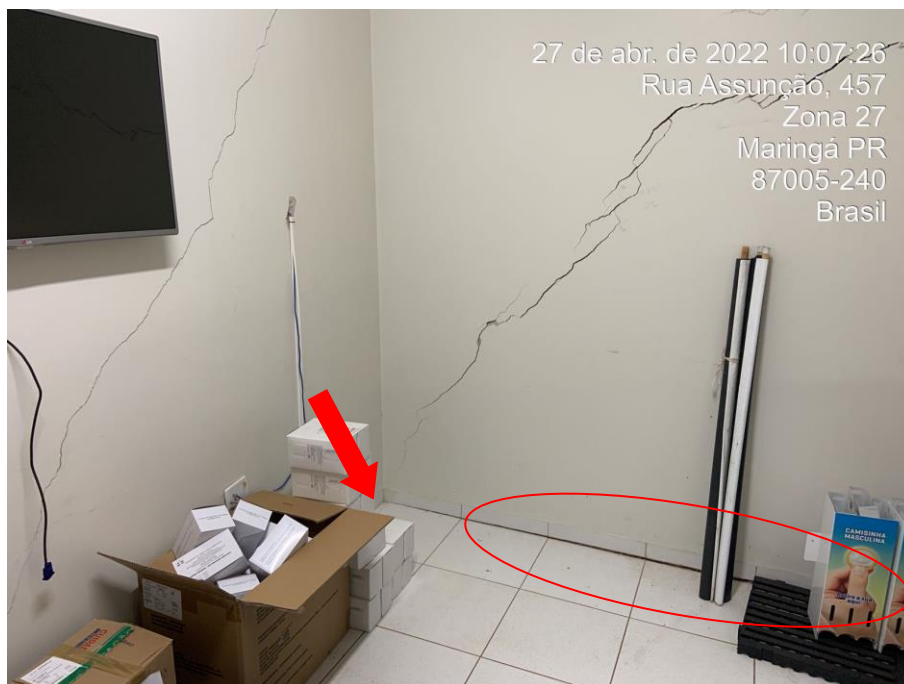
Foto nº 80. Vista parcial da sala 53, destacando trincas de conformação diagonal em alvenaria e acomodação do piso.
