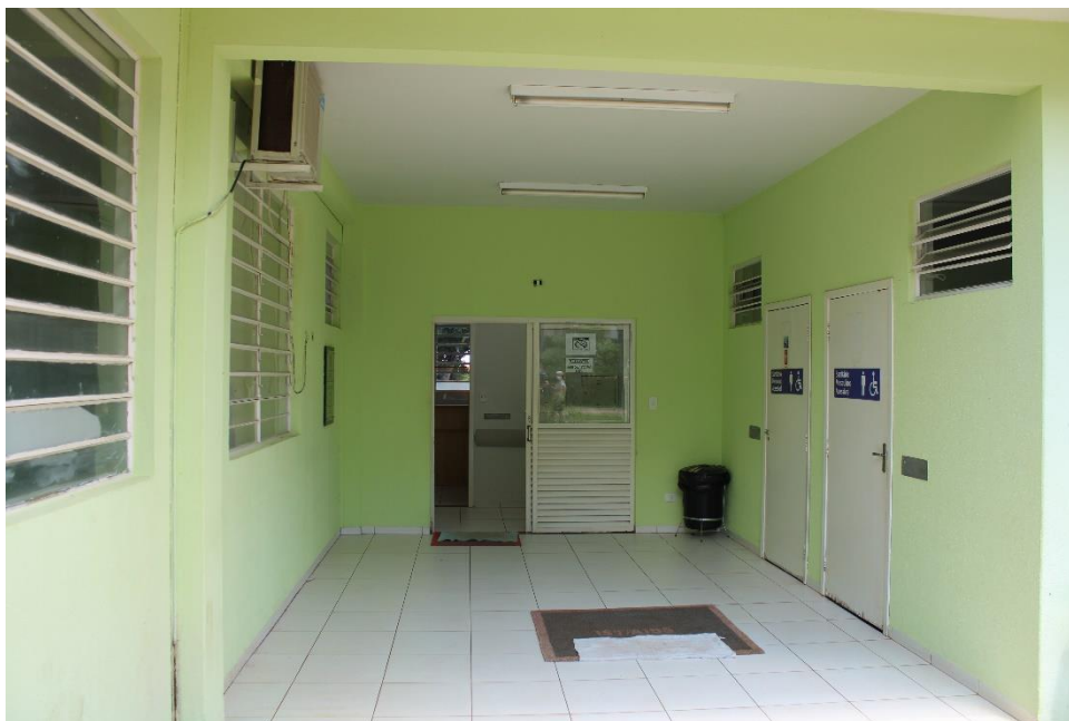
Foto nº 129. Vista da varanda.
