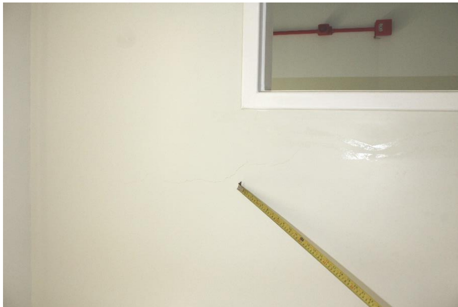
Foto nº 119. Em detalhe a foto supra.
