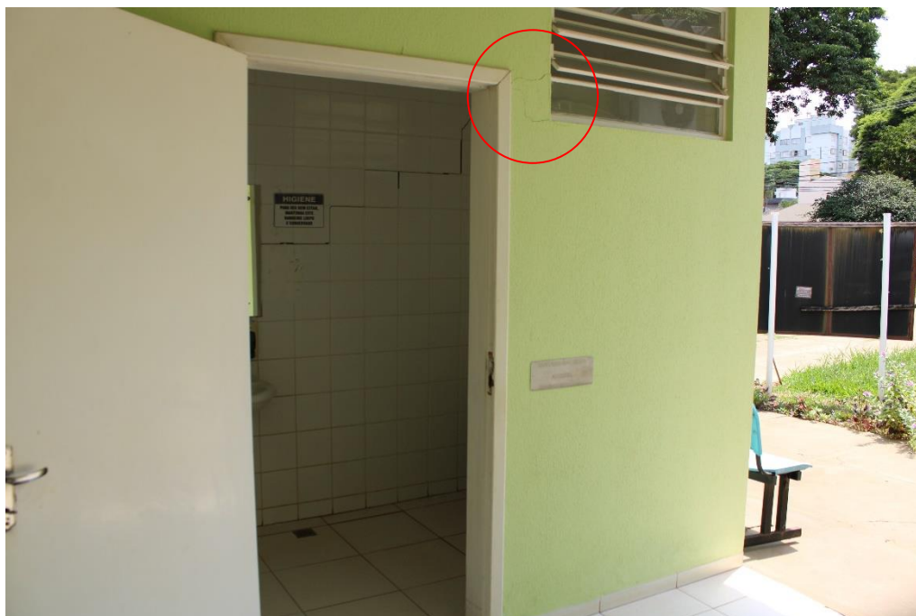
Foto nº 120. Vista do BWC masculino, localizado nas proximidades com a varanda.
