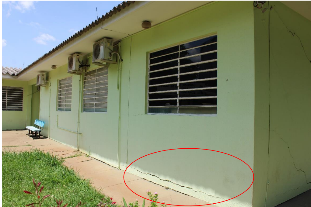
Foto nº 47. Vista da Fachada Lateral Esquerda.
