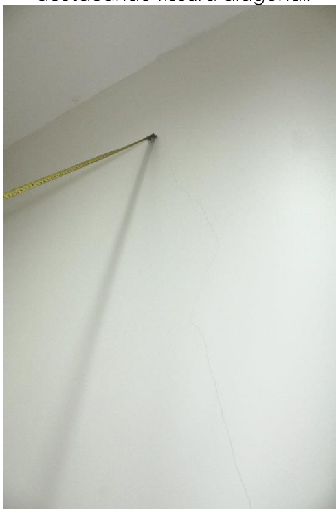
Foto nº 191. Em detalhe a Foto supra.
