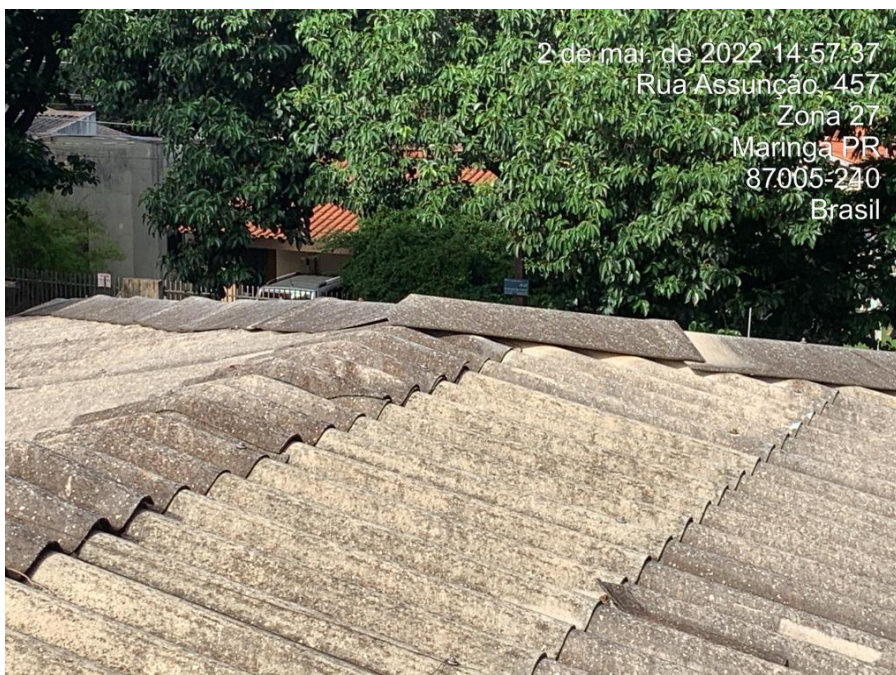
Foto nº 210. Em detalhe a Foto supra.
