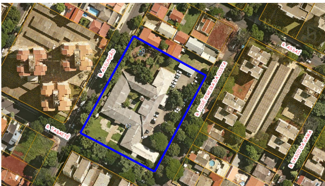
Figura 1: Imagem de satélite, onde se encontra delimitada em azul a área da Policlínica Zona Sul. Fonte: GeoPortal Maringá (2022).
