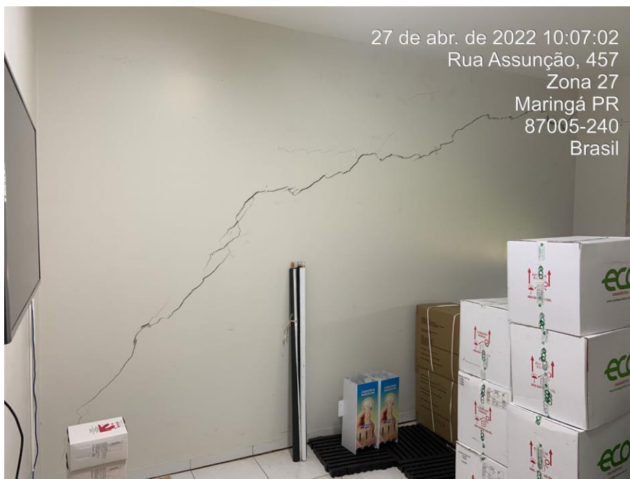
Foto nº 79. Vista parede frontal da edificação, visualizada internamente pela sala 53, destacando trincas de conformação diagonal.
