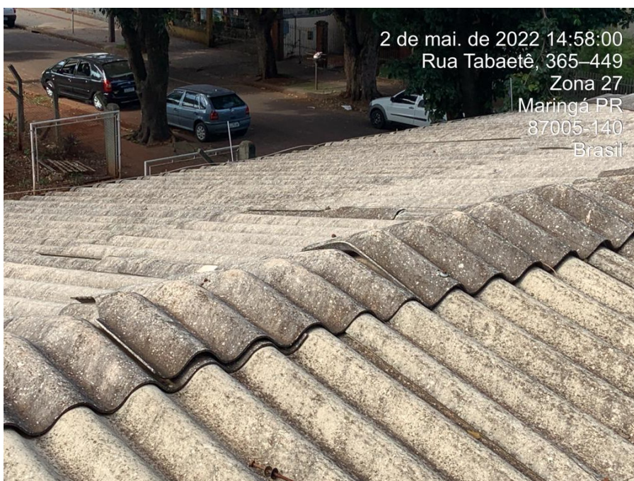
Foto nº 211. Em detalhe a Foto supra.
