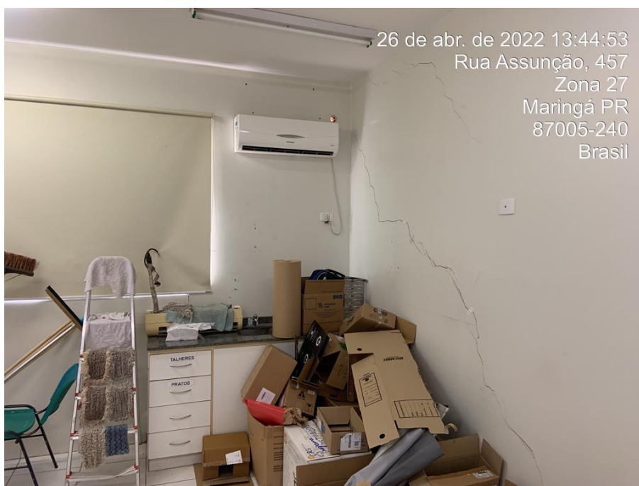
Foto nº 109. Vista parcial da sala 50, destacando trincas diagonais em alvenaria.
