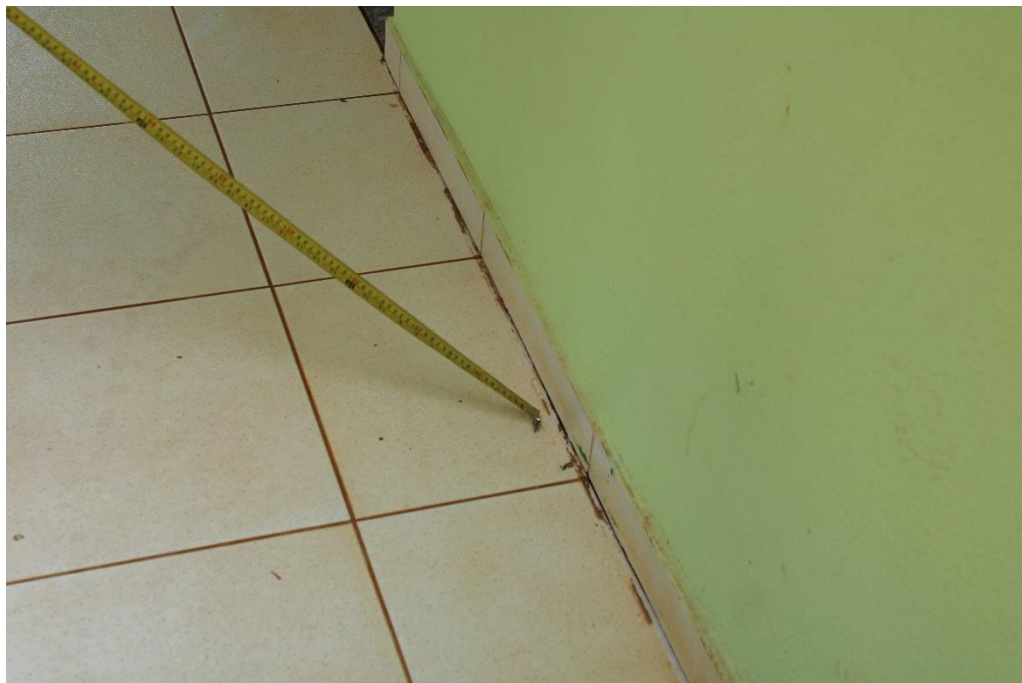
Foto nº 20. Em detalhe a Foto supra.
