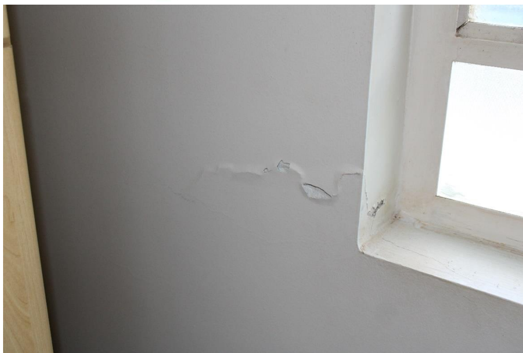
Foto nº 144. Em detalhe a Foto 142.
