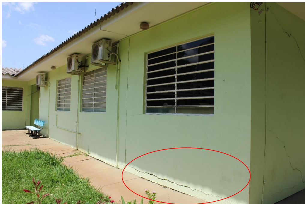
Foto nº 47. Vista da Fachada Lateral Esquerda.
