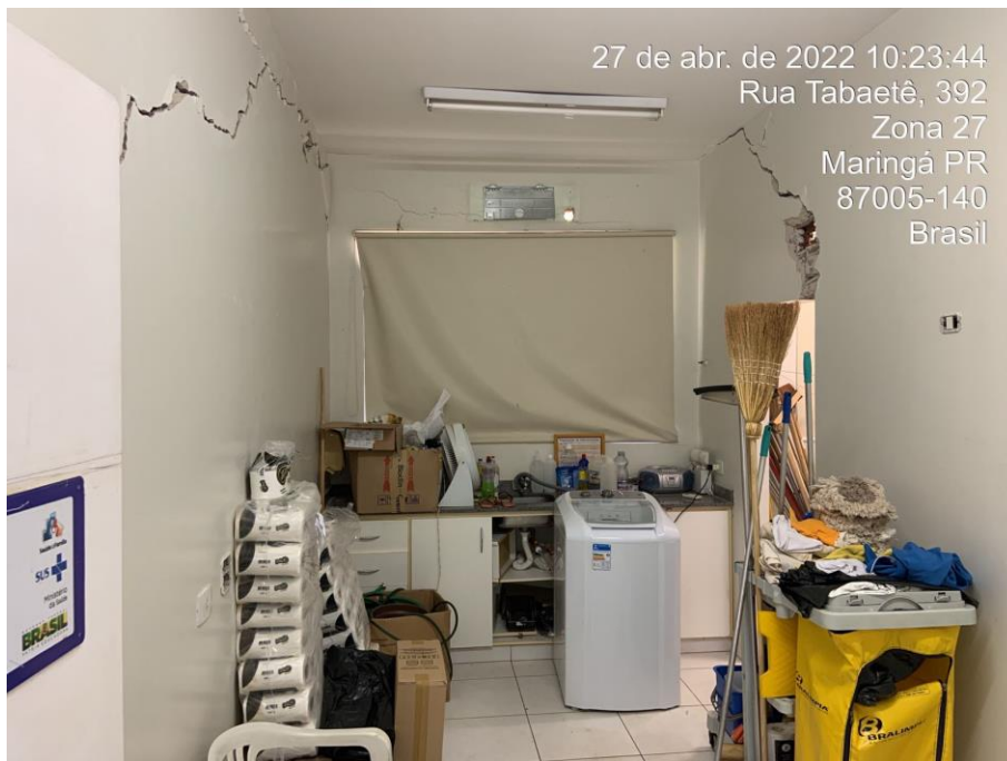
Foto nº 101. Vista da sala 52, destacando trincas transpassantes em alvenaria.
