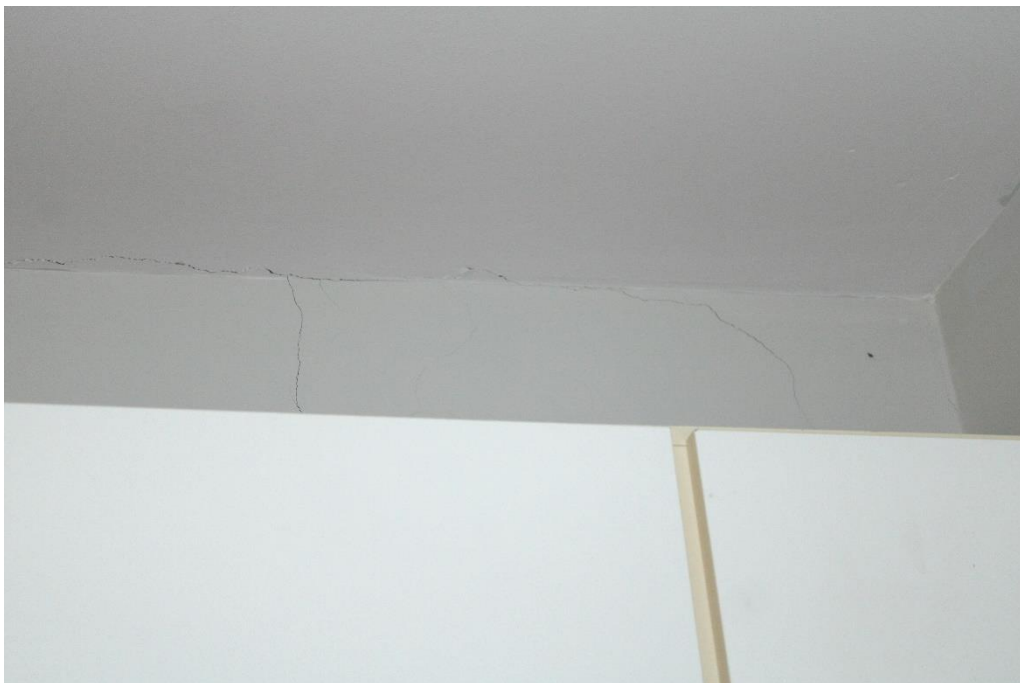
Foto nº 195. Em detalhe a Foto supra.
