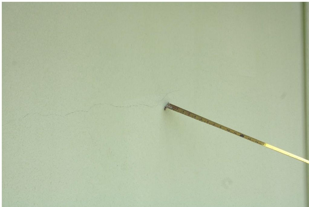
Foto nº 64. Em detalhe a Foto supra.
