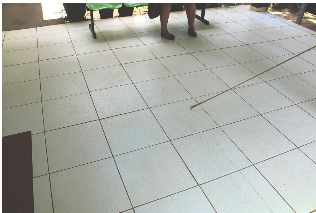
Foto nº 18. Em detalhe a Foto supra.
