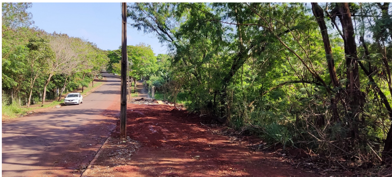
Imagem 01 – Rua Pion. Guarino A. Basseto - Fundo de vale do Loteamento Ebenezer
