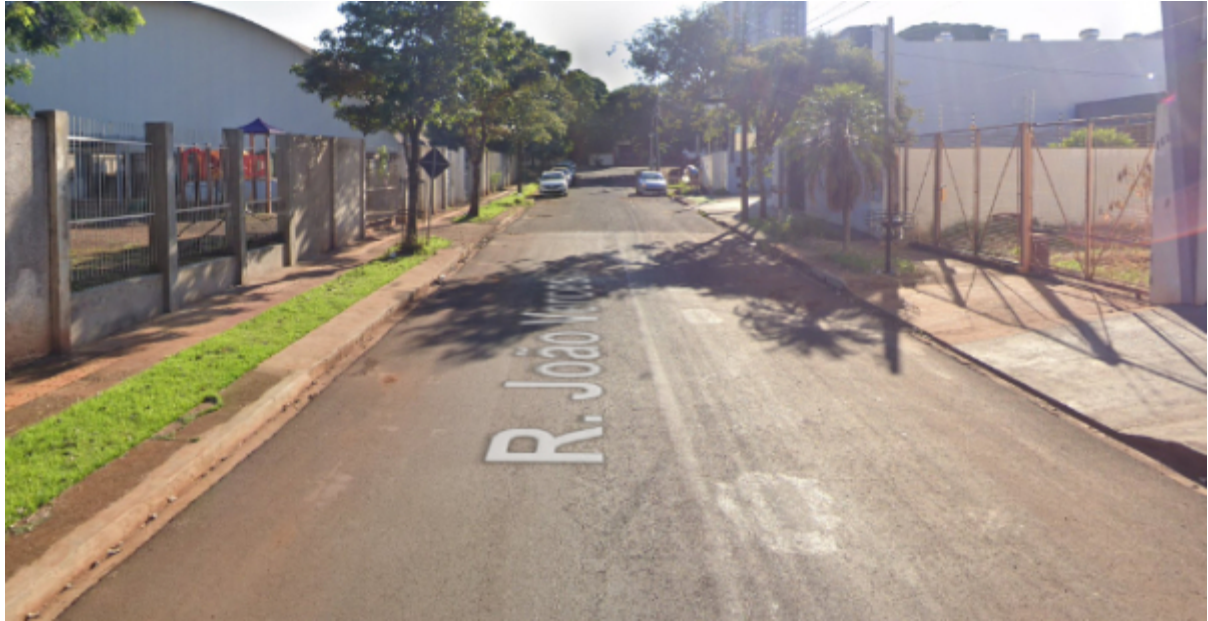
Figura 7 – Comparativo entre lados da calçada na Rua João Vercesi
