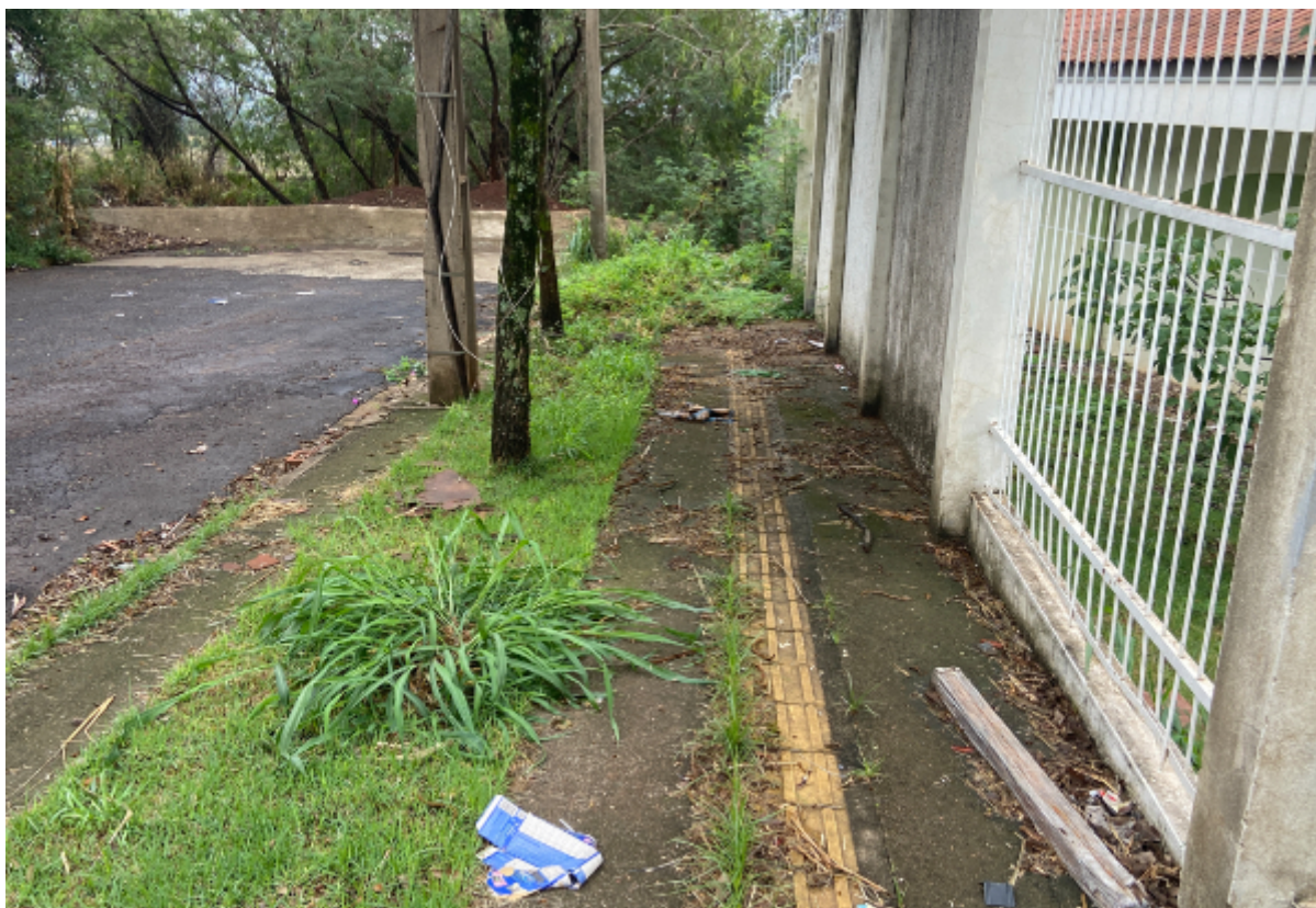
Figura 16 – Piso tátil direcional que leva ao fim da rua sem fechamento
