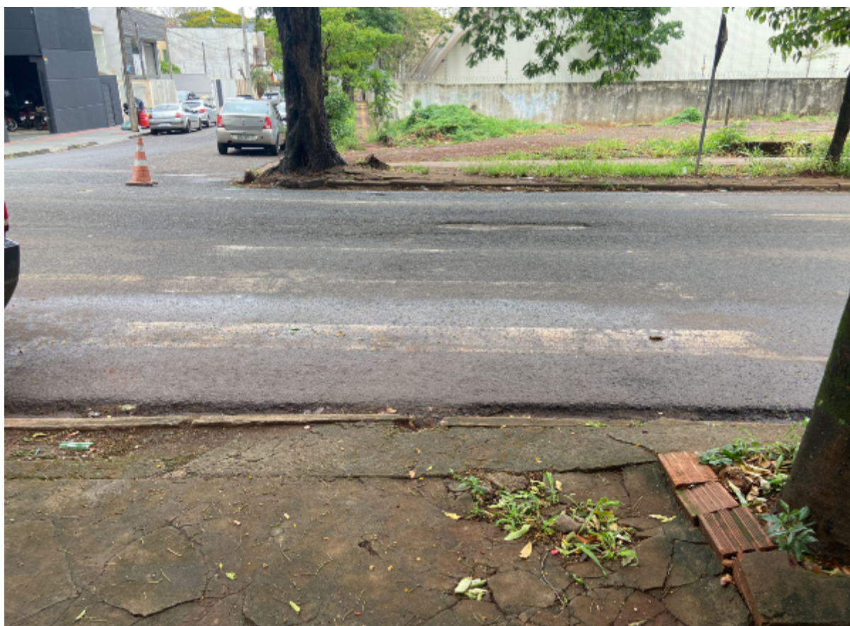
Figura 21 – Faixa de travessia de pedestres com pintura degradada e ausência de rebaixamentos de calçada
